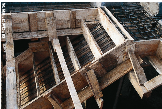
■ Strop i schody z ułożonym zbrojeniem przygotowane do zabetonowania – wcześniej jednak wskazana jest wizyta inspektora nadzoru inwestorskiego, który sprawdzi poprawność wykonania prac
